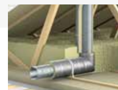
ISOLERING AV VENTILATIONSKANALER PAROC Hvac AirCoat
